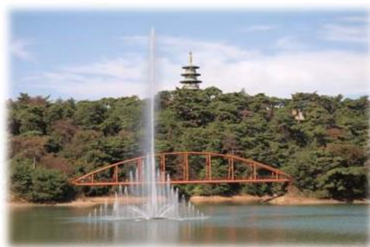
いなべ市（いなべ公園）
